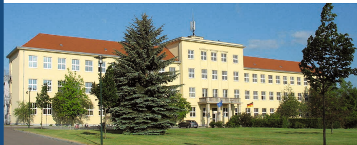
Nach erfolgreicher Sanierung 2003
