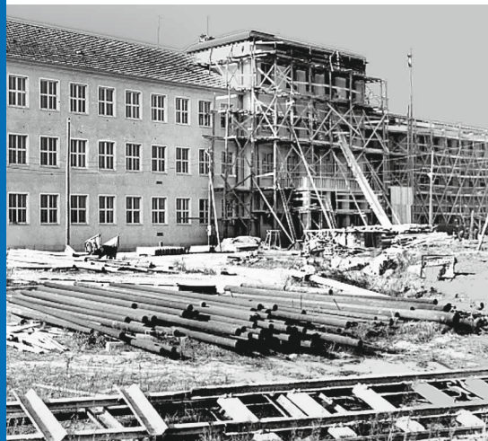
Hauptgebäude in der Bauphase (1952)
